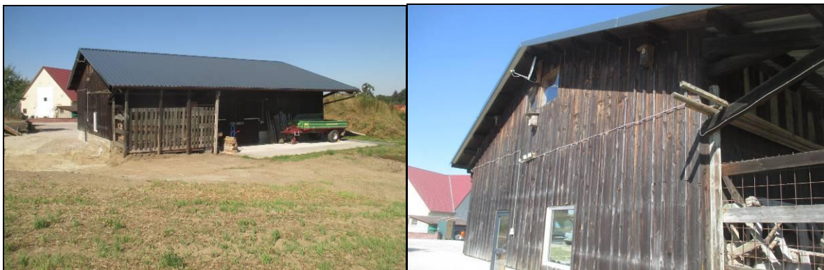
Abbildung 3 Schuppengebäude Rettighofer Weg 7.
