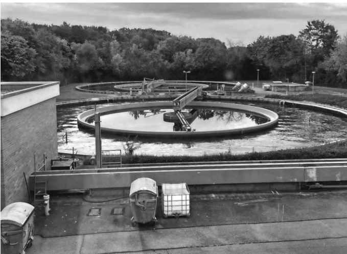
Unsere Bilder zeigen die beiden Klärwärter mit dem schematisch dargestellten Verbandsgebiet und der Kläranlage mit den beiden Belebungsbecken.
